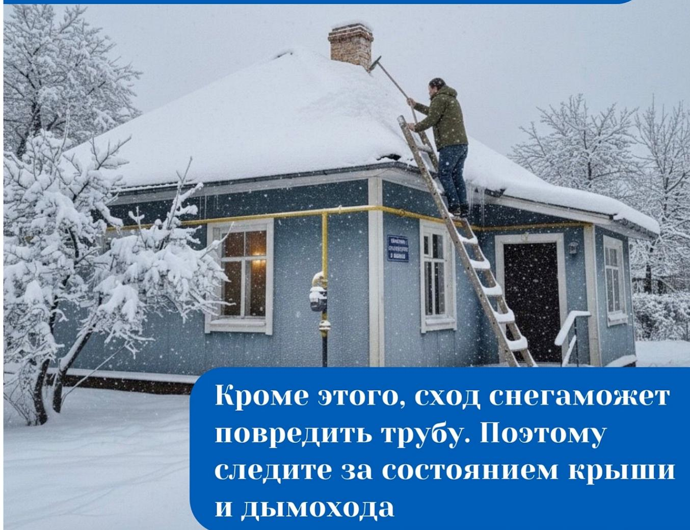
**Кроме этого, сход снега может повредить трубу. Поэтому следите за состоянием крыши и дымохода**
