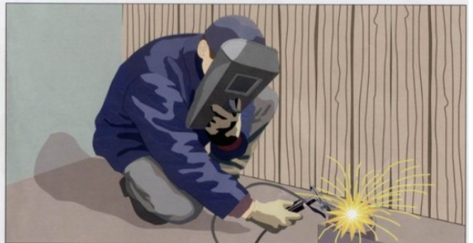
Нарушение правил проведения сварочных работ
