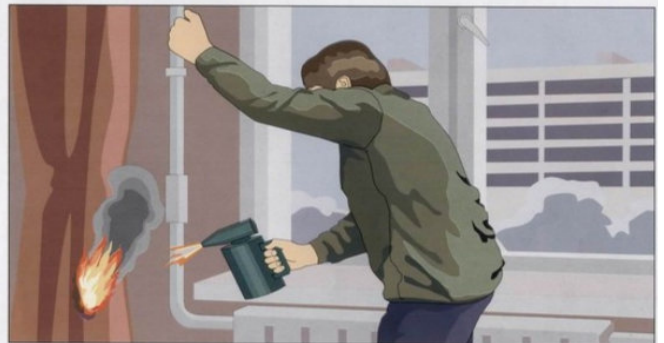
Отогревание замёрзших труб паяльными лампами и факелами
