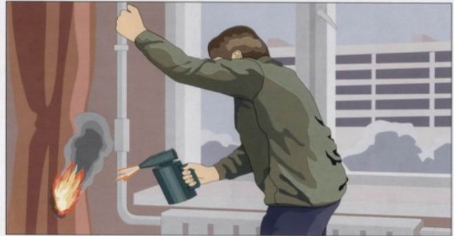
Отогревание замёрзших труб паяльными лампами и факелами
